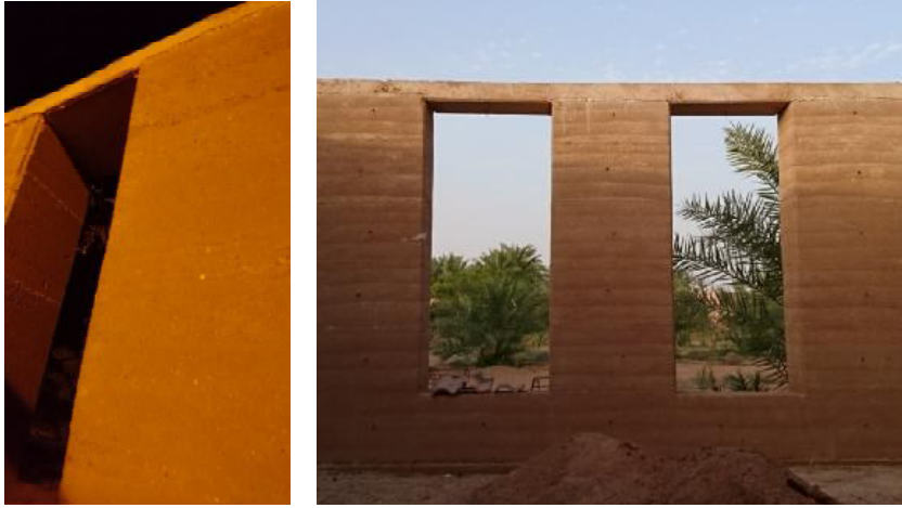
الشكل رقم (١٧). يتضح في الصورة الجسر الرابط الذي يربط بين الحوائط الترابية المختلفة وهو ضروري لإضافة السقف للمبنى
