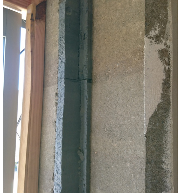
الشكل رقم (١٤). توضح الصورة حائطين ترابين بينهما مادة عازلة، في نيوزيلاندا، ويستخدم العزل في الحوائط الترابية في المواقع الباردة.
