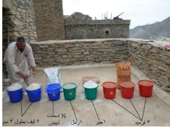
ه. عزل الاسطح باستخدام مواد بناء حديثة تتلائم مع المنطقة
