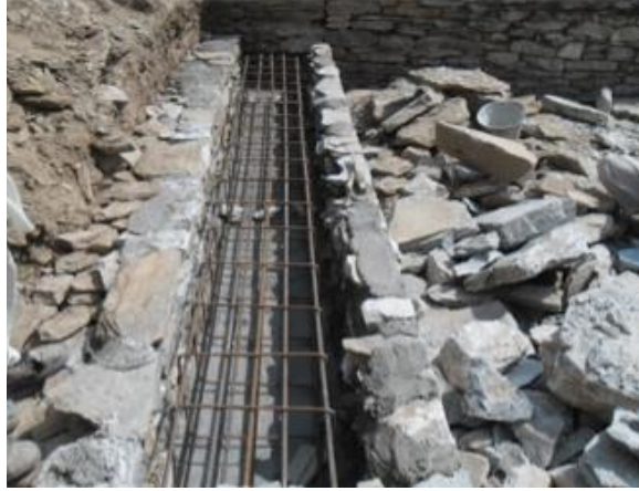
و. تدعيم اساسات المباني بخلطه اسمنتيه وحديد التسليح
