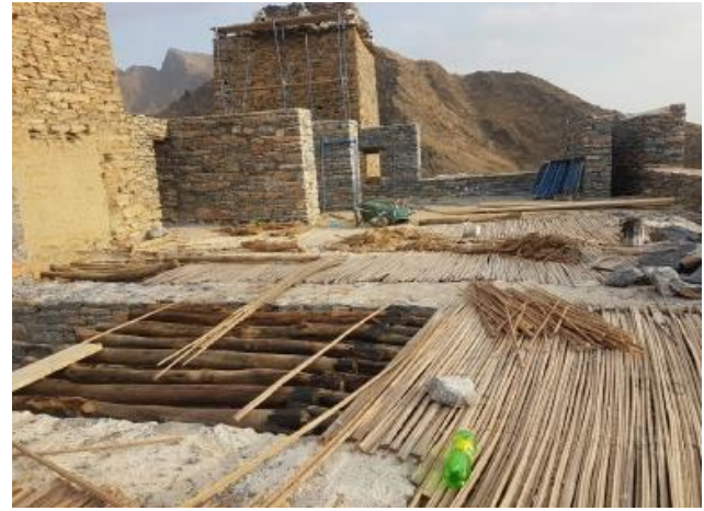
شكل رقم ٨. إستخدام جذوع الاشجار المحلية ومعالجتها ضد عوامل التآكل وتثبيتها بأسلوب يحاكي خصائص المبنى التراثي الاصلي.
