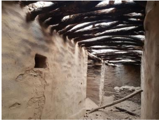
شكل رقم ٨. إستخدام جذوع الاشجار المحلية ومعالجتها ضد عوامل التآكل وتثبيتها بأسلوب يحاكي خصائص المبنى التراثي الاصلي.
