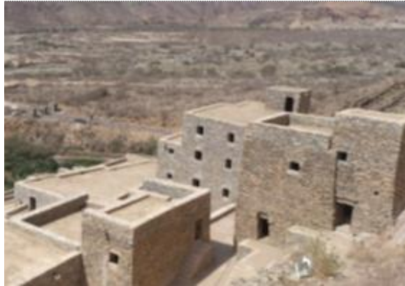
د.ترميم الجدران واعاده بناء الاسقف
